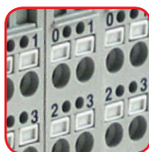
Zacisk sprężynowy i punkty do testowania
