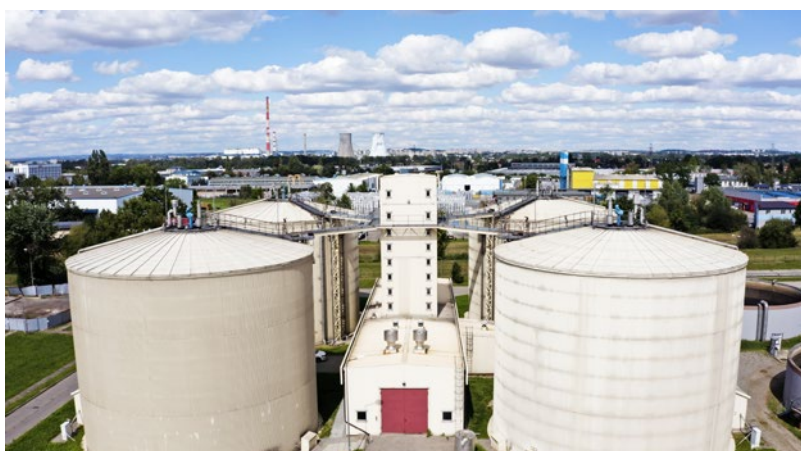
Zakład Oczyszczania Ścieków Płaszów. Źródło: ASTOR
