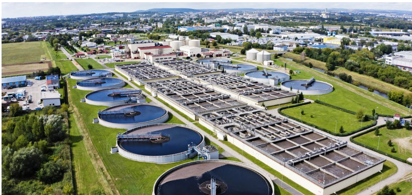
📍 Zakład Oczyszczania Ścieków Płaszów. Źródło: ASTOR
