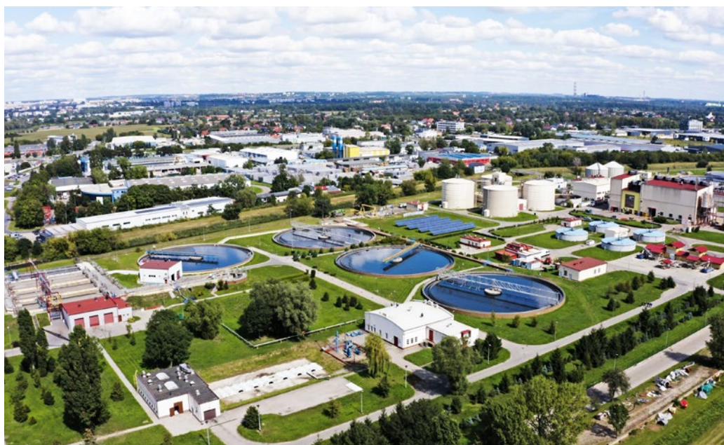
👁 Zakład Oczyszczania Ścieków Płaszów. Źródło: ASTOR
