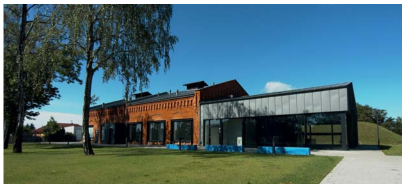
👁️ Budynek SUW Zaborowo po modernizacji
