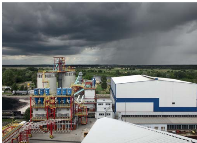
❖ Instalacje starej (prawa strona) i nowej (lewa strona) biomasy
