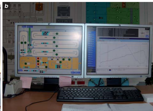
Centralna dyspozytornia – tablica synoptyczna (a) oraz stacja operatorska (b)
