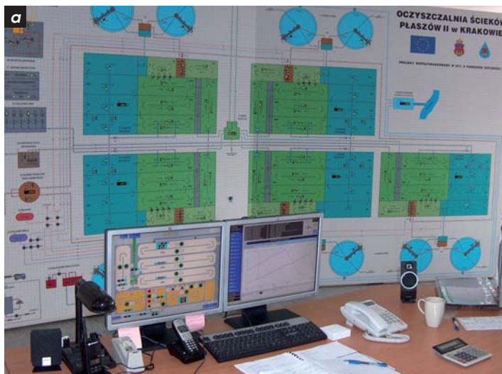
Centralna dyspozytornia – tablica synoptyczna (a) oraz stacja operatorska (b)
