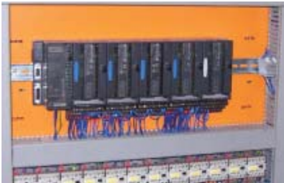
Rys. 2. Sterownik VersaMax w szafie sterowniczej.
