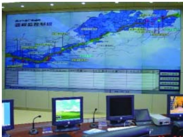
Rys. 1 Industrial Application Server umożliwia regulowanie przepływu wody na długości 700 kilometrów i na 43 służach z centralnej stacji dyspozytorskiej
