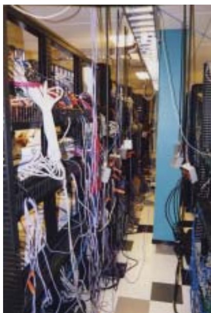
Okablowanie komputerów testowych
