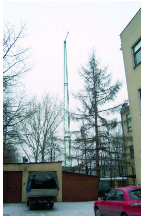
Rys. 4. Maszt antenowy stacji bazowej przy siedzibie głównej MPEC Mielec
