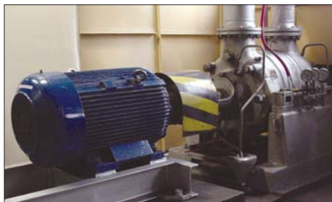
Pompa obiegowa nr 1 z nowym napędem.
