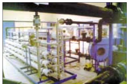
Rys. 3. Odwrócona osmoza — widok rur odwróconej osmozy i zbiornika do ich płukania.
