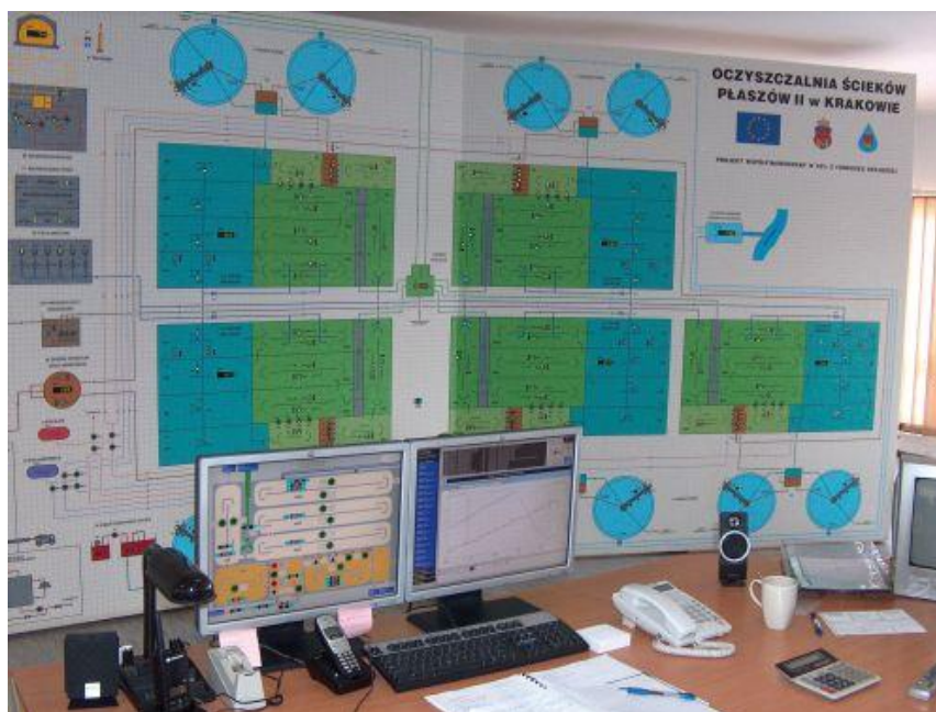
Rysunek 2. Centralna dyspozytornia – tablica synoptyczna
