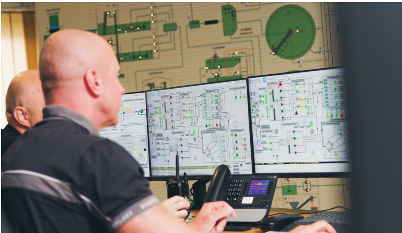
☛ Centrum sterowania w Zakładzie Oczyszczania Ścieków Płaszów
